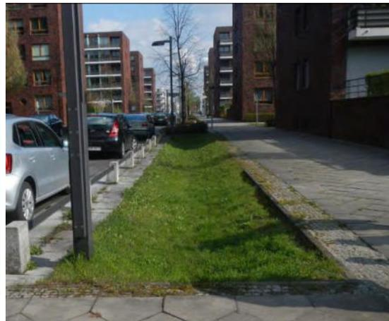
Abbildung 2: Schematische Darstellung einer Versickerungsmulde links und Umsetzung in öffentlicher Verkehrsfläche rechts (Quelle: Bayerisches Landesamt für Umwelt, Augsburg; Sieker)
