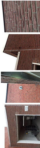
Foto 28 bis 31: leere Garage, Metallatten eng gearbeitet, ohne Potenzial
